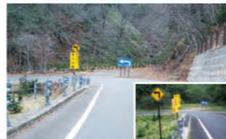
改善箇所の一例(標識集約による改善) 左:改善後 右:改善前
